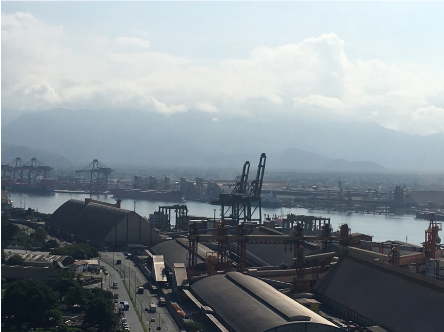
FIGURA 1 Entrada do canal do Porto de Santos, em abril de 2017
