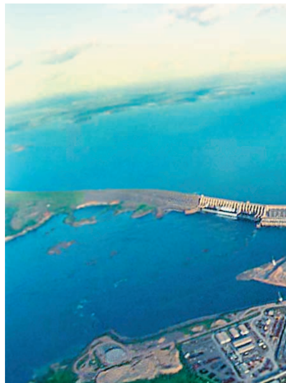
Construção das eclusas no rio Tocantins, junto à usina
