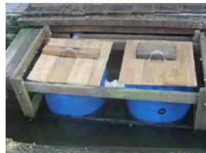
é composto por um tanque séptico e filtro anaeróbio, formado por anéis de bambu, pedra britada e cacos de tijolo.
