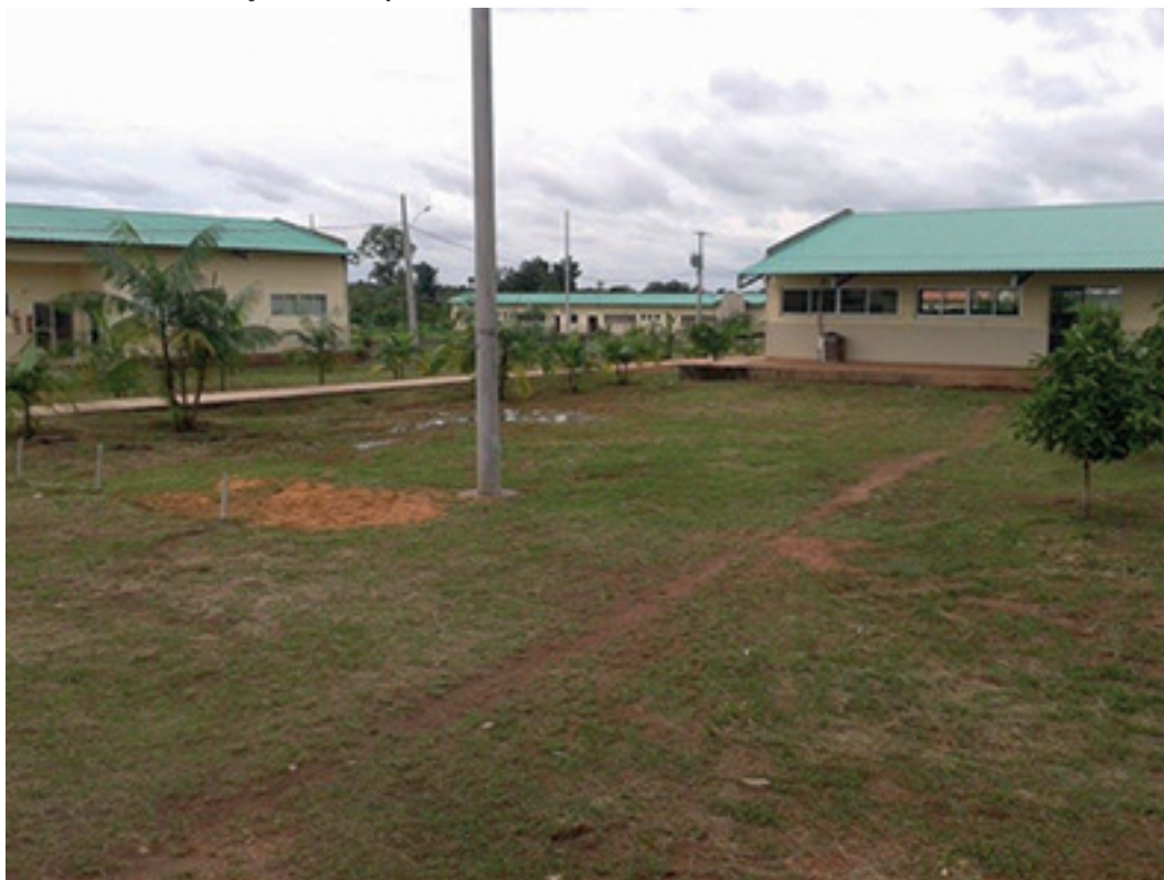
FIGURA 3 Marabá: instalações do Campus Rural do IFPA
