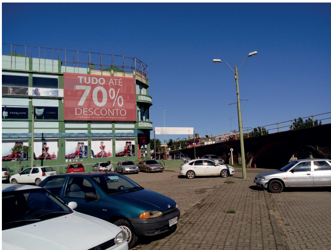
FIGURA 3 Los free shops y la cabecera del Puente
