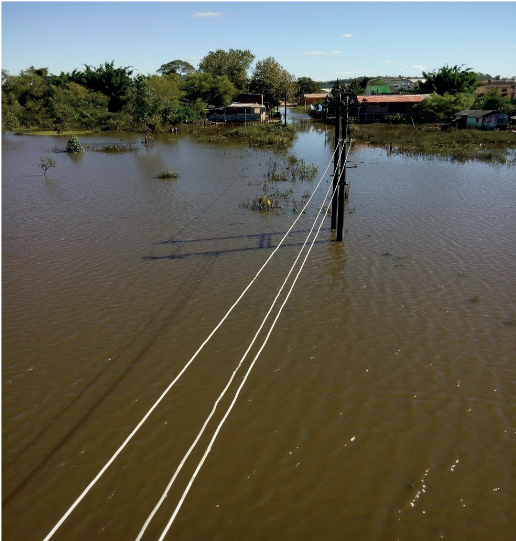
FIGURA 4 Calles inundadas debido a la reciente crecida del Río Yaguarón, en abril de 2016
