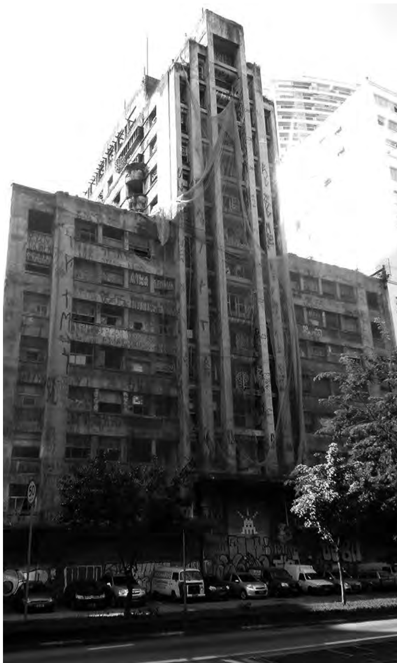
FIGURA 4 Edifício do INSS (avenida Nove de Julho)
