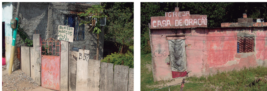
FIGURA 1 Residência e igreja com marcações B57 e C56 sinalizando remoção no bairro Trio de Ouro, São João de Meriti
