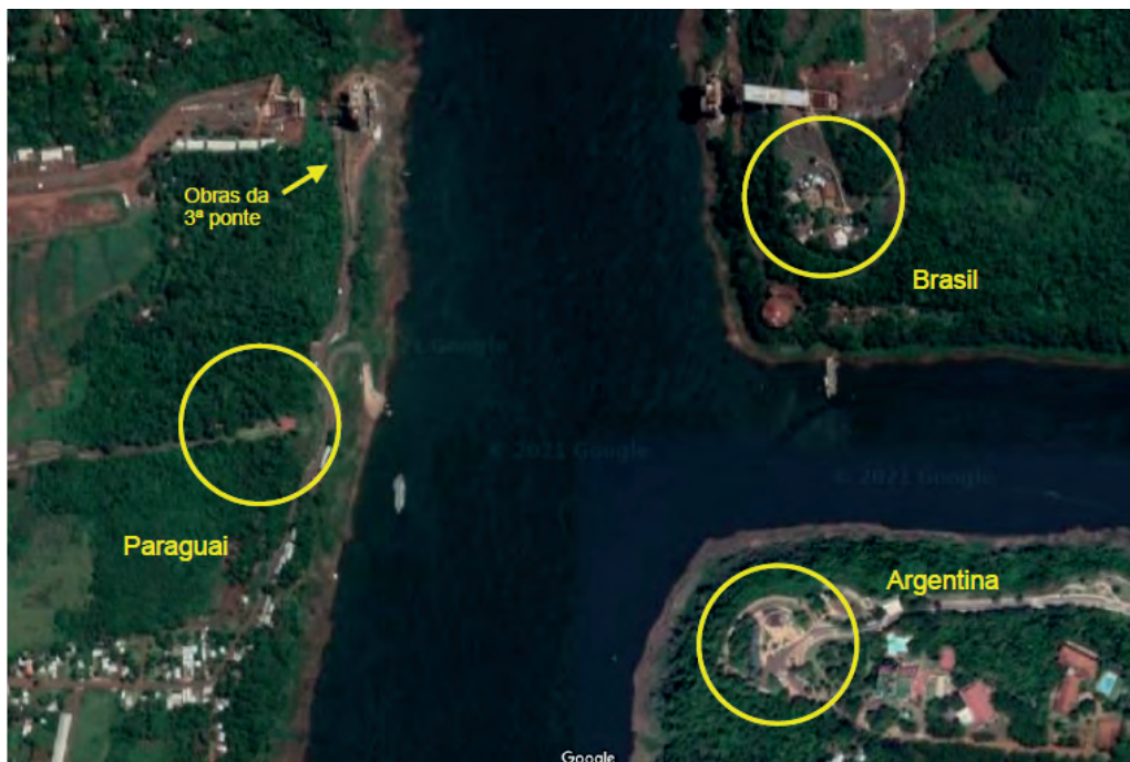
FIGURA 26 Obras da Ponte da Integração
