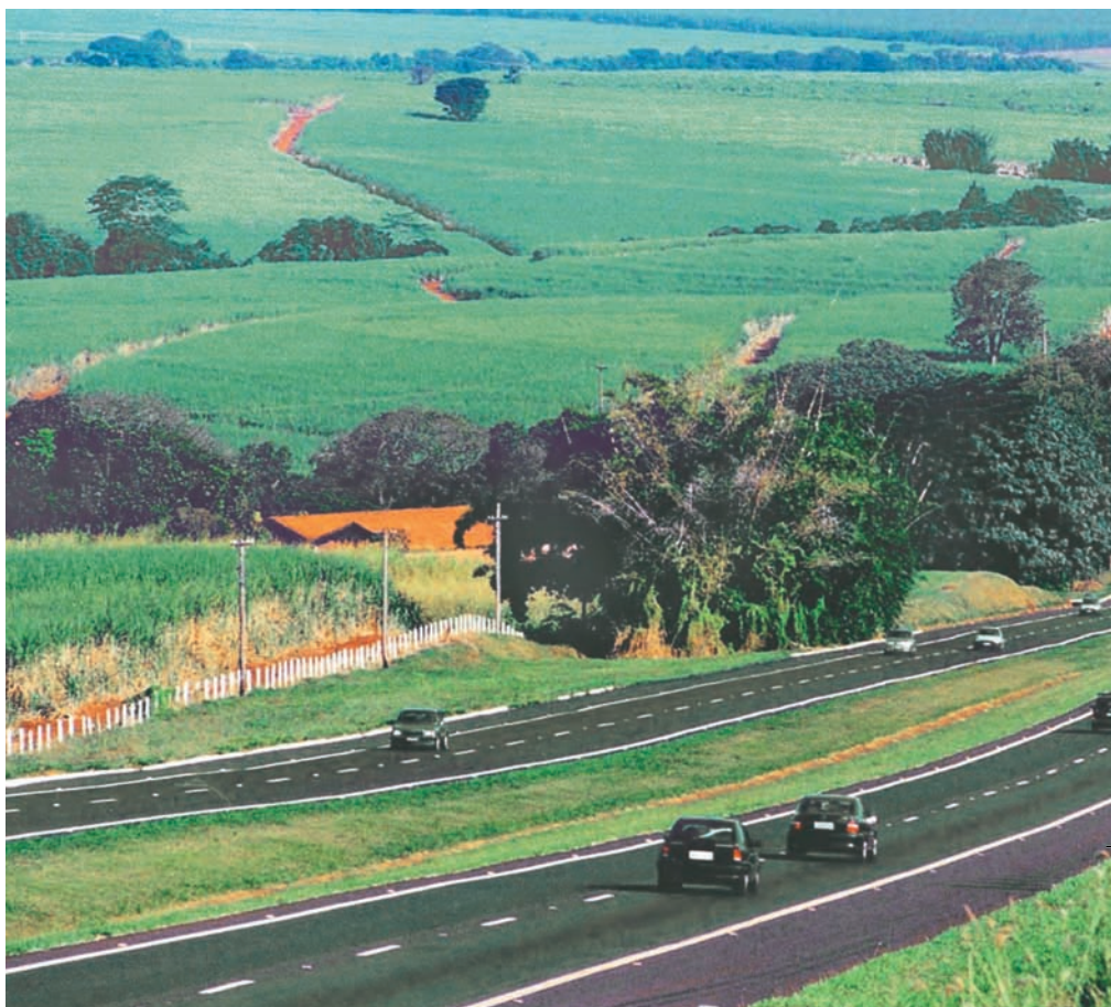
Nova pista da Rodovia dos Imigrantes, que liga São Paulo à Baixada Santista, construída pela Ecovias; e
