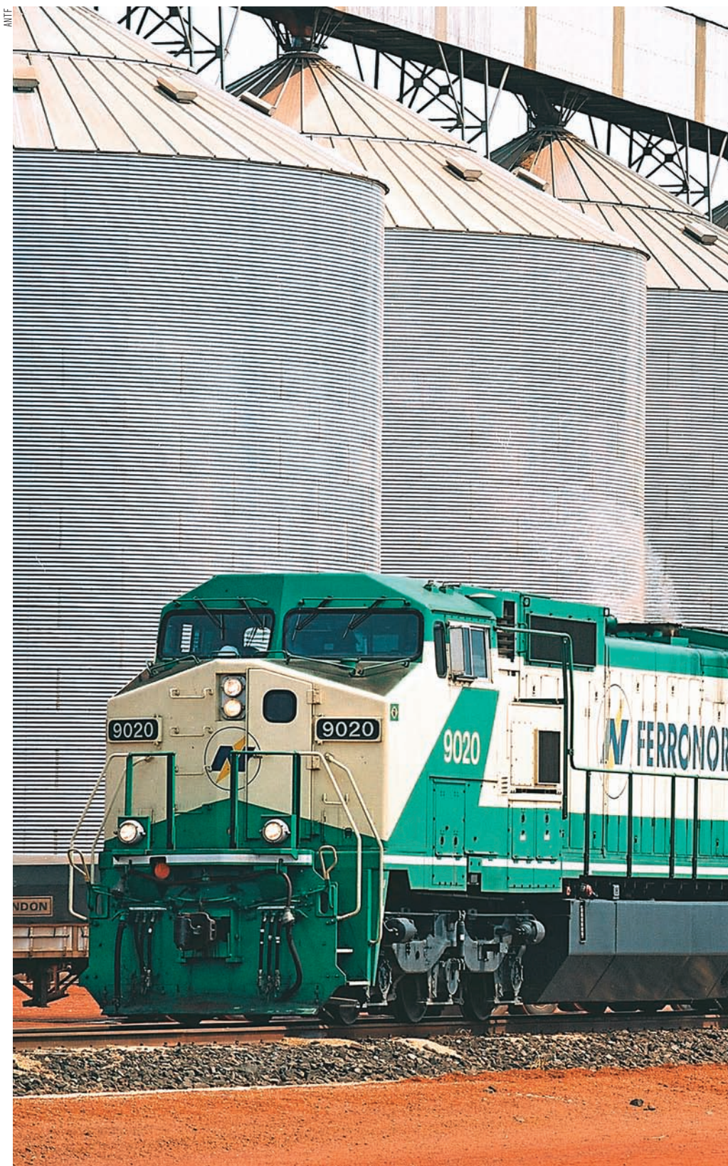
Terminal do Alto Taquari, no Mato Grosso, da Ferronorte: a construção dessa malha, na década de 90,
