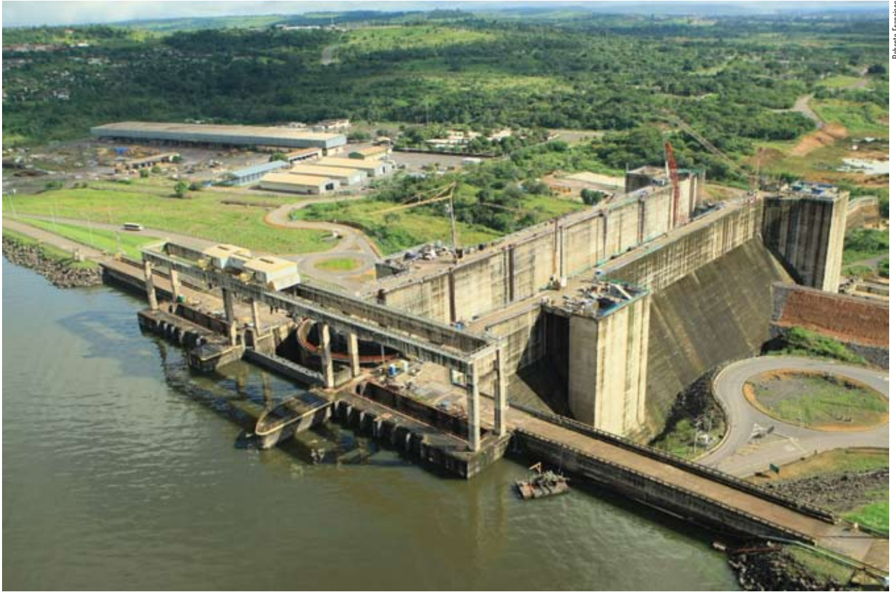
Hidrelétrica do Tucuruí, Tocantins-PA
