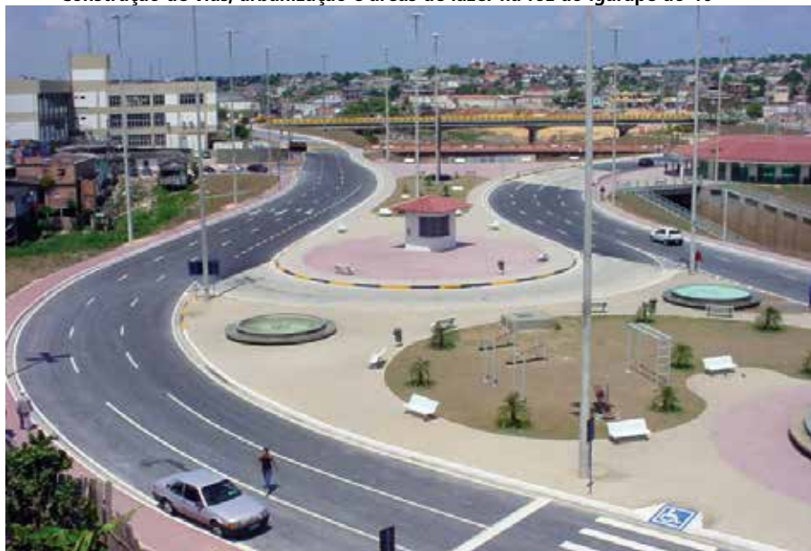
FIGURA 20 Construção de vias, urbanização e áreas de lazer na foz do igarapé do 40
