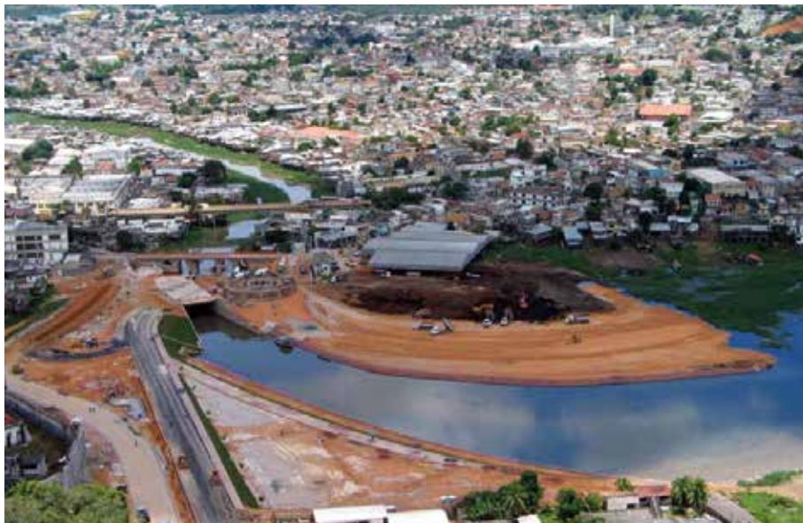
Vista aérea do avanço das obras às margens do igarapé do 40
