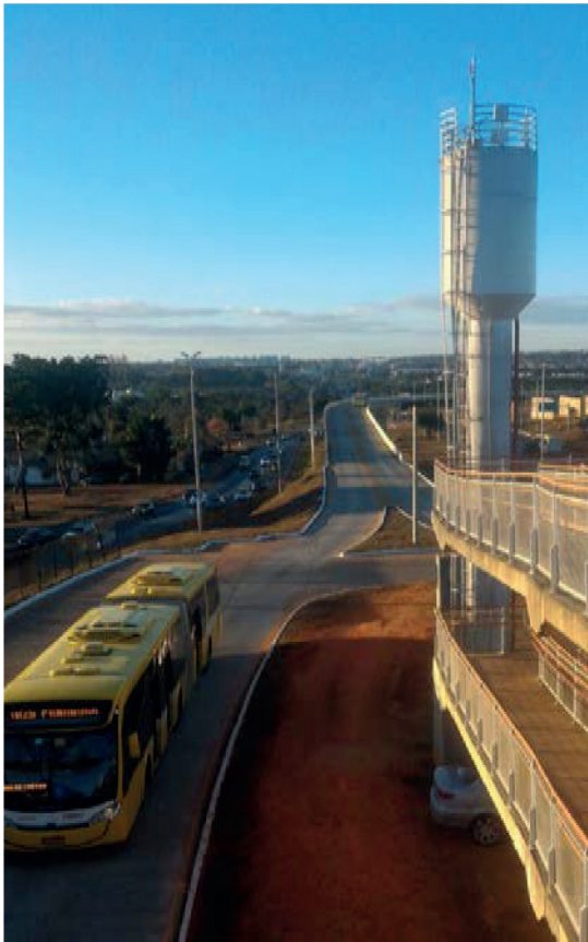
FIGURA 1 Viaduto da estação do Park Way
