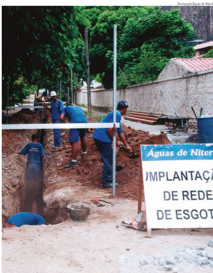
Obras da concessionária Águas de Niterói, de capital privado: resultados eloquentes em todos os quesitos
