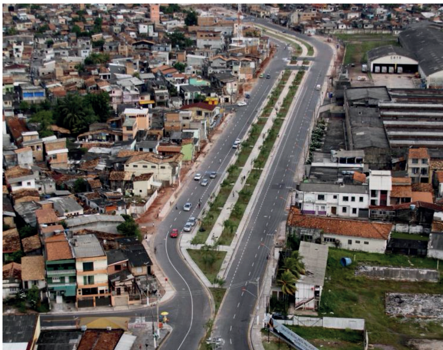
Figura 2. Trecho de intervenção viária na Bacia Hidrográfica da Estrada Nova, em Belém.
